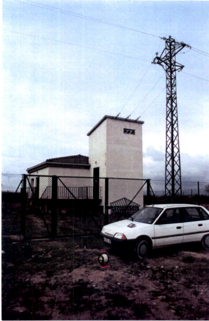
FOTO 1: Exterior de la captación de aguas subterráneas.
