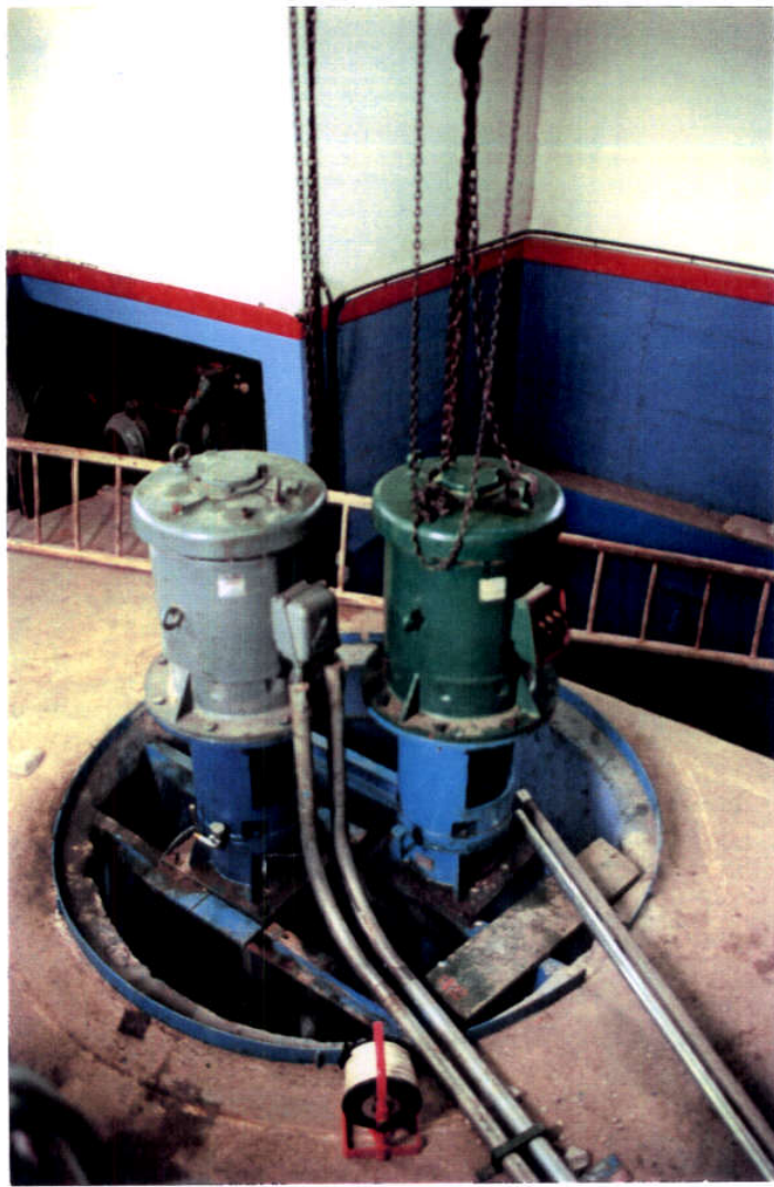
FOTO 2: Interior de la captación.
